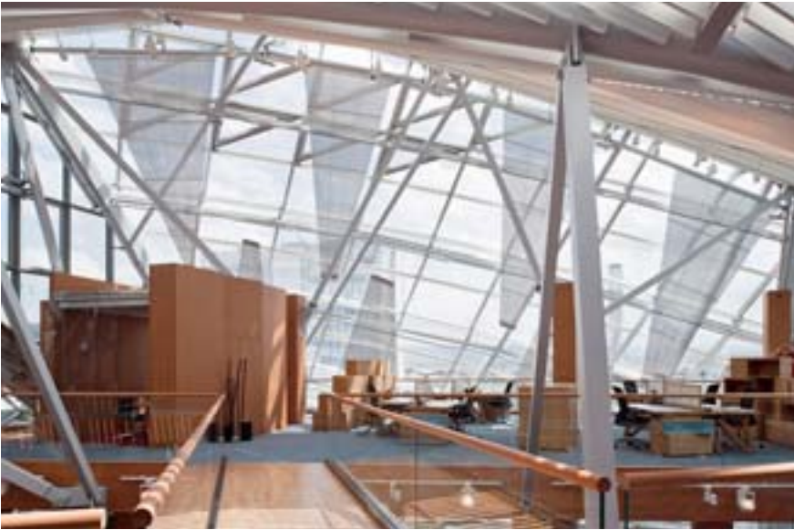
Jede der 417 Gegenzuganlagen ist individuell gefertigt und mit schwer entflammarem Polyester-gewebe bespannt.
