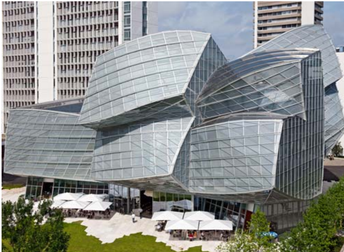
Die dekonstruktivistische Architektur mit Freiformfassade aus Glas stellte hohe Ansprüche an Sonnen- und Blendschutz.
