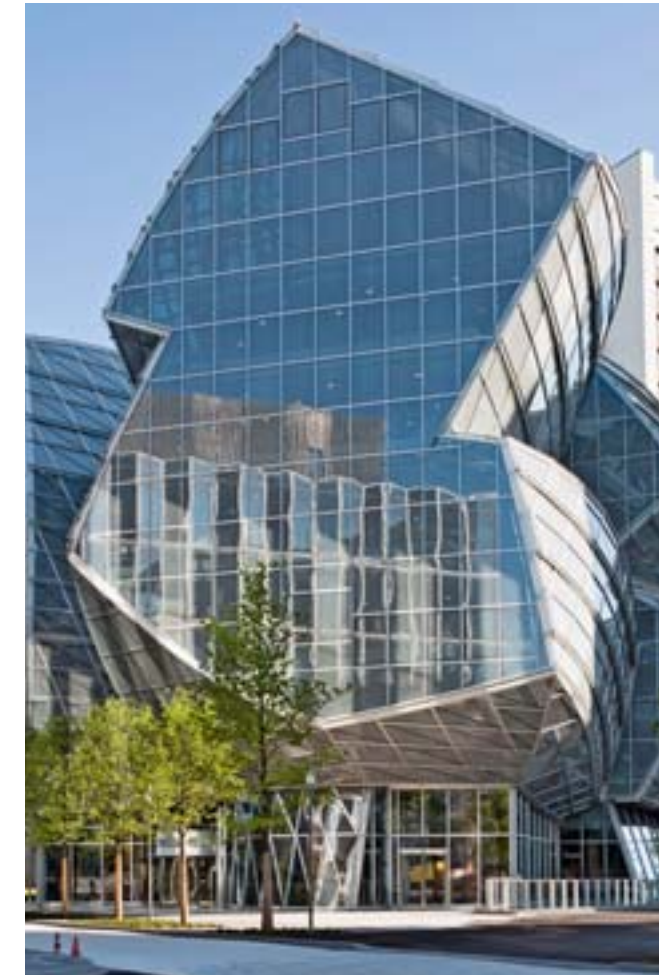
Ohne architektonische Beeinträchtigung werden die großen Glasflächen von innen verschattet.
